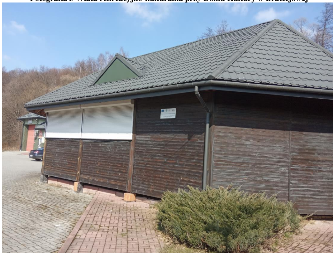
Fotografia 3 Wiata rekreacyjno-kulturalna przy Domu Kultury w Braciejowej
