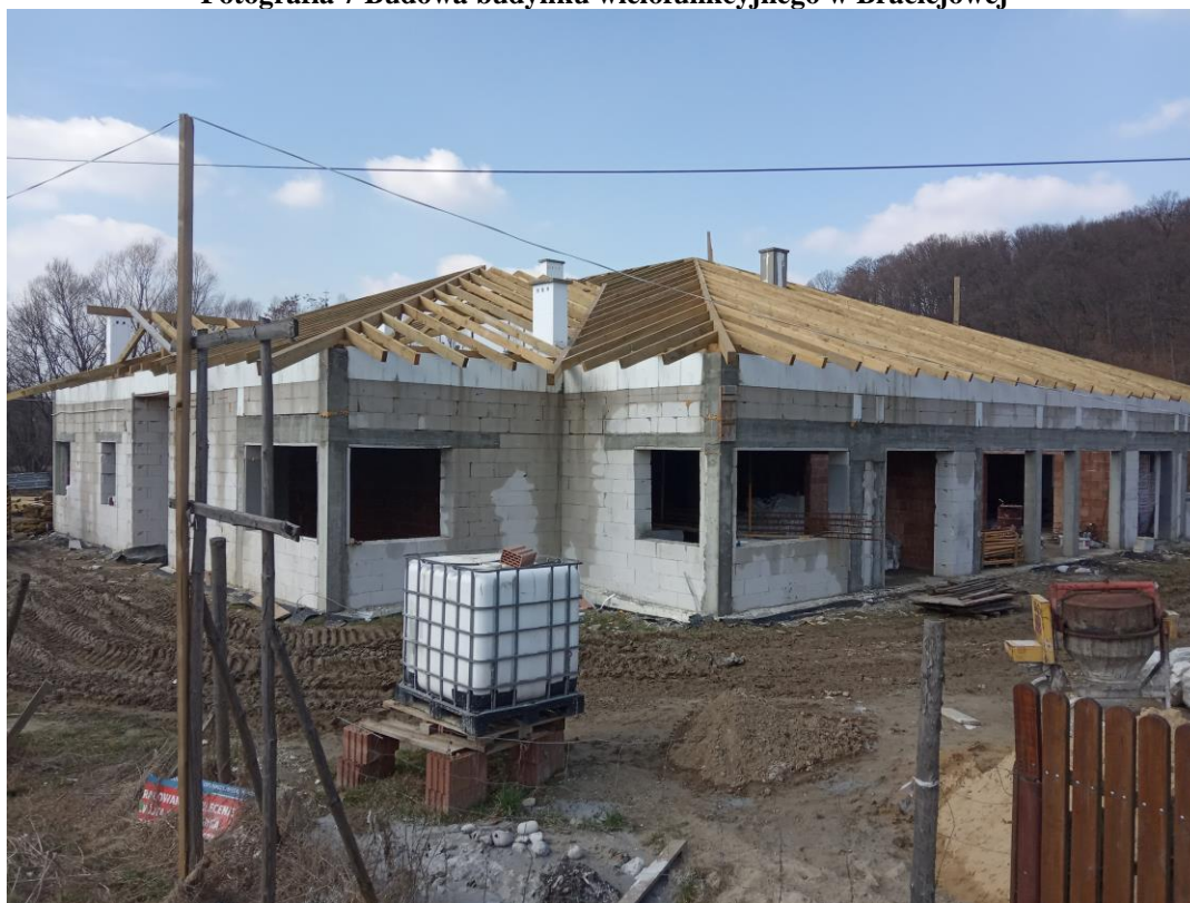
Fotografia 7 Budowa budynku wielofunkcyjnego w Braciejowej
