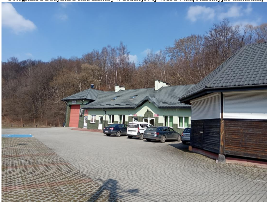
Fotografia 2 Budynek Domu Kultury w Braciejowej wraz z wiatą rekreacyjno-kulturalną
