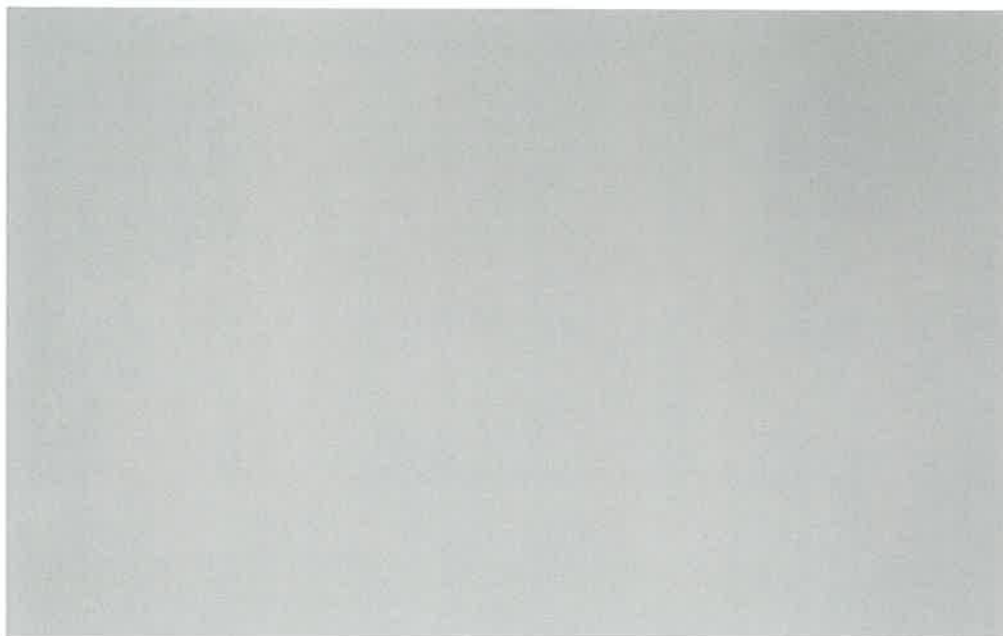
Zdj. nr 5 powierzchnia stropu do malowania
