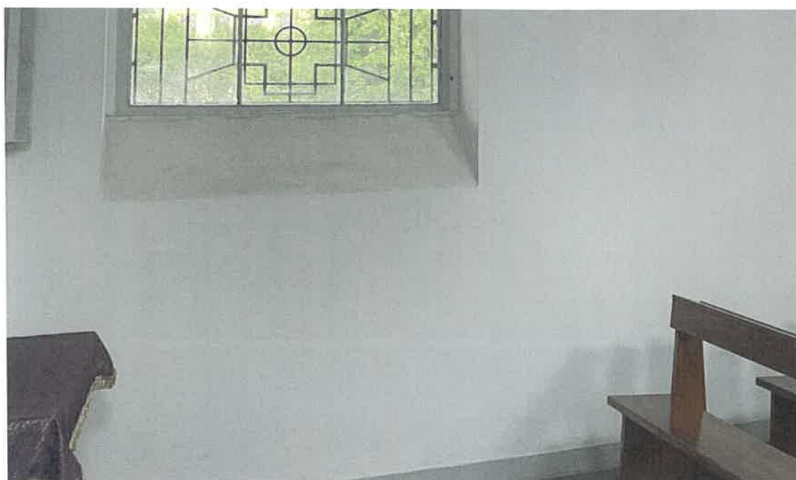
Zdj. nr 4 powierzchnia ścian gładkich do malowania
