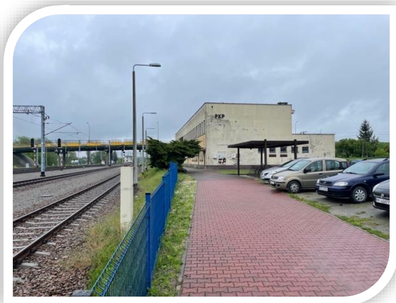
Fotografia 8. Ropczyce - dworzec kolejowy
